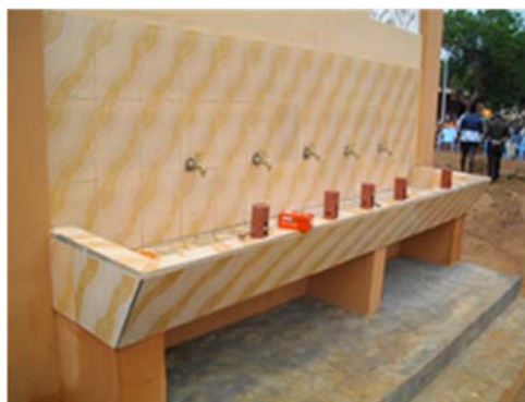
Assainissement école de Tsévié
