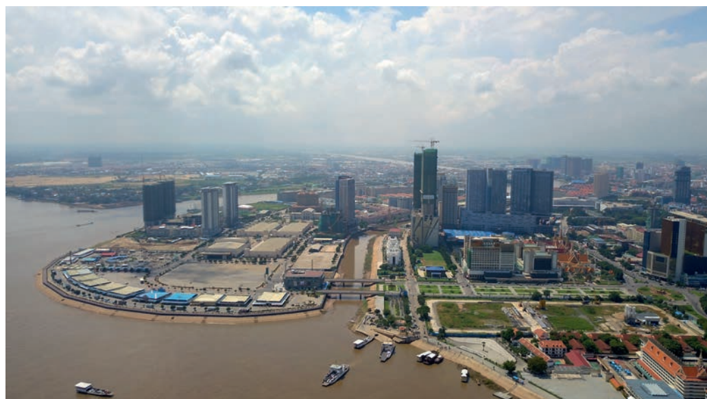
L'île de Koh Pich en construction en 2018.
