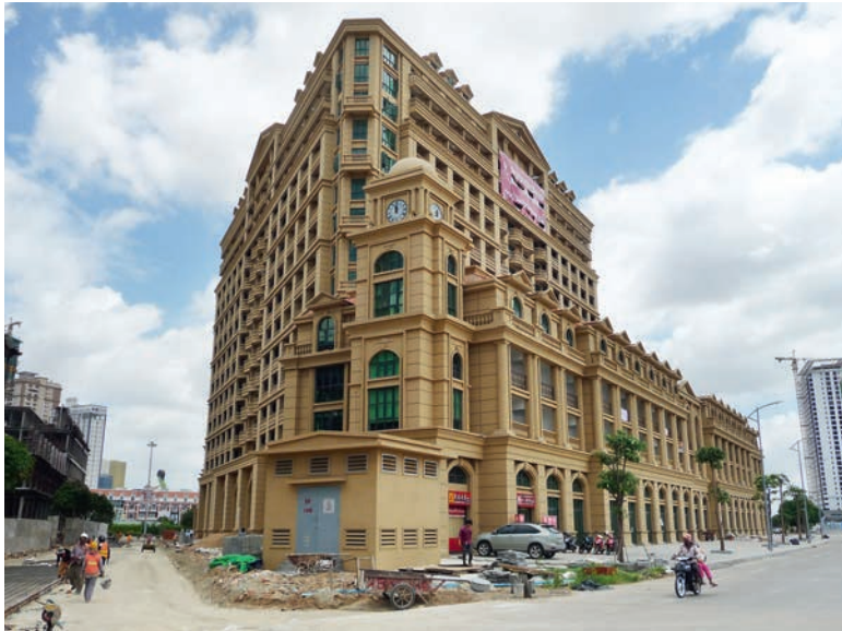
Ile de Koh Pich, immeuble de logement de style néo-classique en construction, Phnom Penh – 2018.
