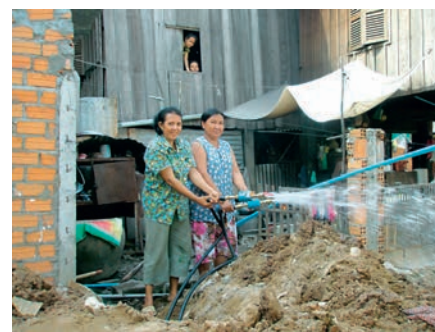
Branchement des habitants au réseau d'eau potable PPWSA.
