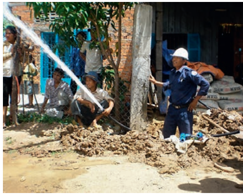
Les travaux d'installation du réseau d'eau potable (PPWSA).
