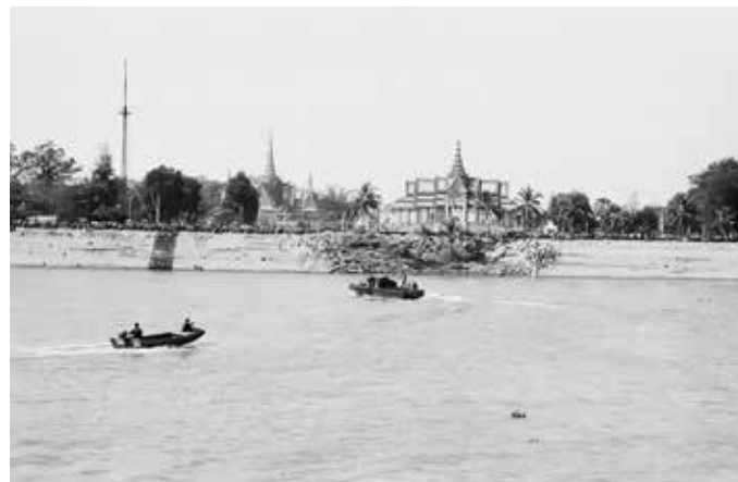
Face au Palais Royal, le perré du quai du Tonlé Sap écroulé, 1979.
