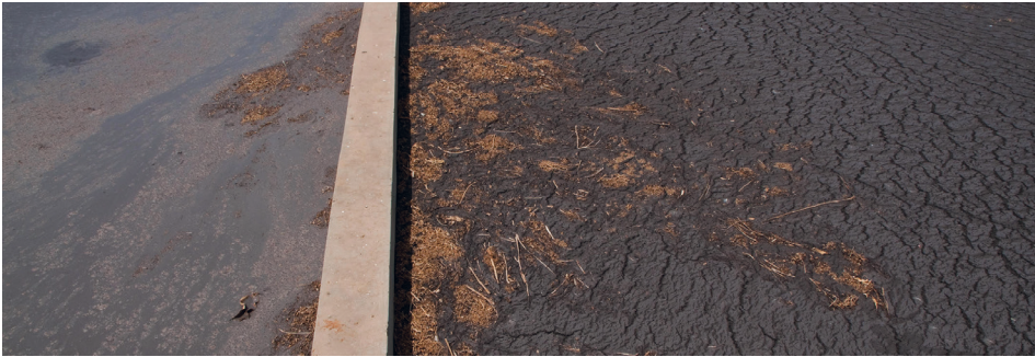
Figure 7.2 : Boues de vidange fraîchement déversées et partiellement déshydratées sur les lits de séchage non-plantés de la station de traitement des boues de vidange de Niayes, Dakar, Sénégal (photo : Linda Strande).
