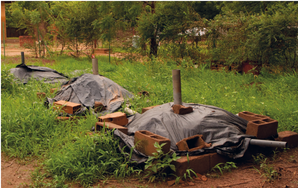
Figure 3.9 : Biodigesteurs à l'école 2iE de Ouagadougou, Burkina Faso (photo : Linda Strande).
