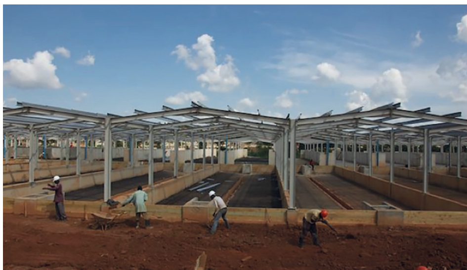
Figure 18.1 : Lits de séchage pour le traitement des boues de vidange en cours de construction sur le site de Lubigi à Kampala. Étape 1 du projet de protection du lac Victoria financé par la KFW, l'UE et le gouvernement ougandais (NWSC) (photo : Lars Schoebitz).
