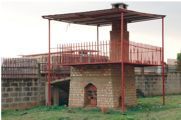
Figure 18.6 : Le four pilote du projet FaME (Faecal Management Enterprises) pour la cocombustion des boues de vidange destinée à la production de briques à Kampala, Ouganda (photo : Pitman Ian Tushemebwe).
