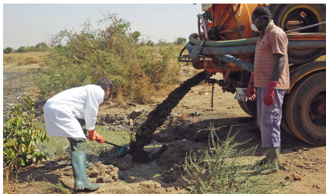
Figure 2.4 : Campagne de prélèvement pour quantifier et caractériser les boues de vidange à Ouagadougou, Burkina Faso, en vue de la conception de la nouvelle station de traitement des boues de vidange (photo : Hanspeter Zoellig).
