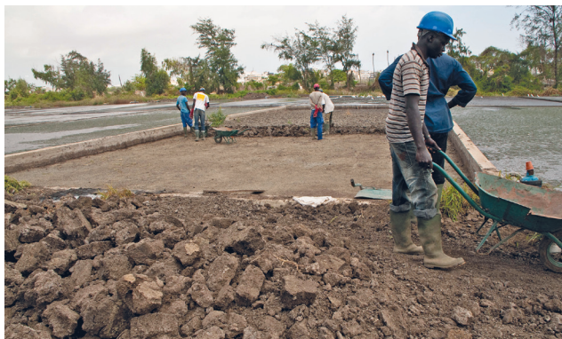
Figure 7.5 : Curage des boues de lits non-plantés à la station de traitement de Cambérène, Dakar, Sénégal (photo : Linda Strandle).
