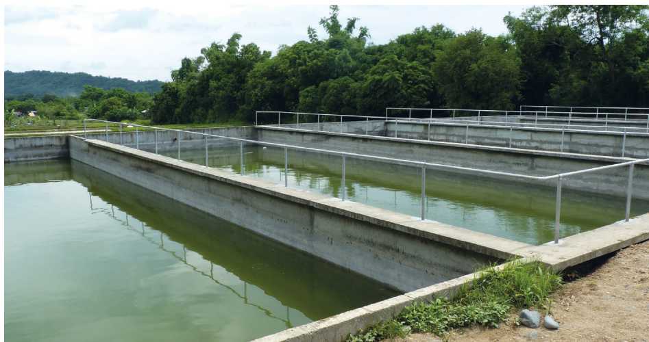
Figure 11.8 : Mise en exploitation d'un système de lagunage pour le traitement de boues de vidange à San Fernando, Philippines. Dans ce cas, les bassins de lagunage ont été inoculés avec des boues d'une station de traitement des eaux usées située à proximité (photo : David M. Robbins).
