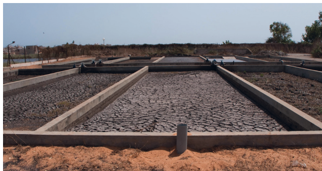
Figure 3.4 : Lits de séchage de la station de traitement des boues de Niayes, Dakar, Sénégal (photo : Linda Strande).
