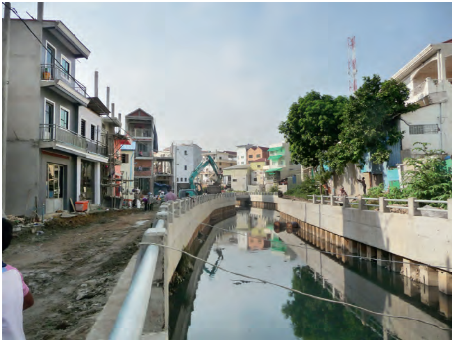
Programme de relogement de populations pauvres le long du canal du Stung Meanchey.
