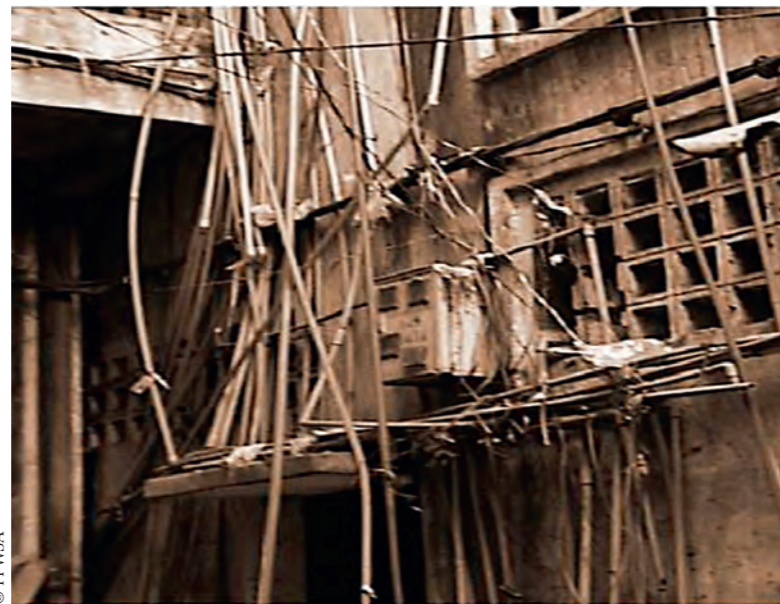
Chaque famille installe son tuyau d'arrivée d'eau. Each family installs its water supply pipe. គ្រួសារនីមួយៗតែងតែដំឡើងទឹកចូលក្នុងផ្ទះរបស់ខ្លួន
