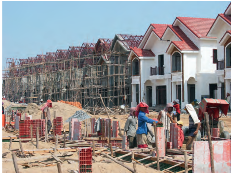
Chantier de construction d'un borey sur la presqu'île de Chrui Changvar.
