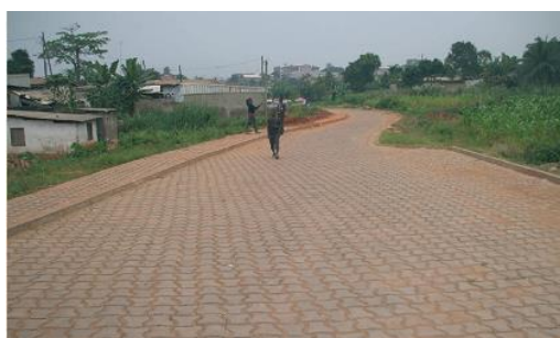
Chaussée en béton et ne pavé à Melen
