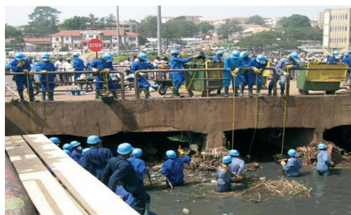
Curage du collecteur souterrain du Mfoundi
