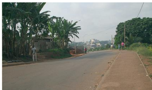
Chaussée en enrobés à Nkolndongo
