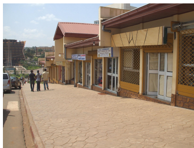
Construction des boutiques
