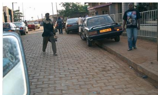
Chaussée en béton et en pavés à Briqueterie
