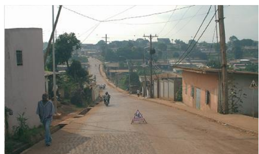
Chaussée en béton à Kondengui
