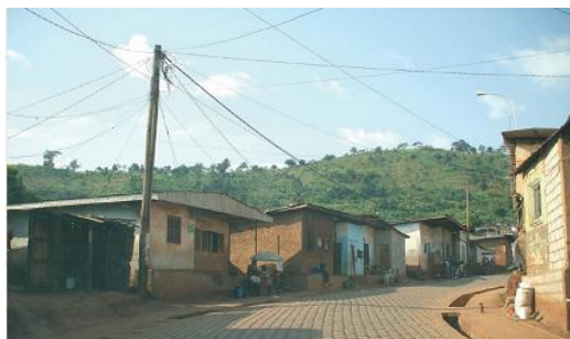
Chaussée en enrobés à Messa Carrière
