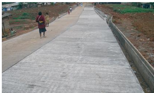
Chaussée en enrobés à Essos-Sud
