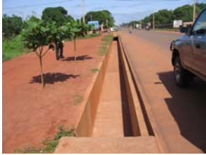
Abomey, assainissement de l'avenue
